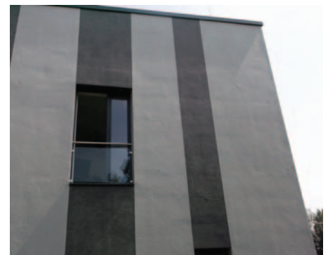
8. kép. Hivatalosan (lásd: MÉVSZ THR Kivitelezési Irányelv 23. Felületképzés minősítése**) „nem illik” surló fényben felületet minősíteni, de az értékeléshez hasznos segítséget nyújt. Ilyen esetben jól érzékelhetőek felületeldolgozási hiányosságok (egyenetlen, szakszerűtlen vakolateldolgozás)
