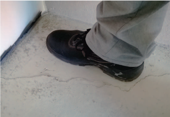
1–2. kép. A burkolatlan (!) jellemzően 3–3,5 cm vastag esztrich terhelés hatására letört helyiségsarok
