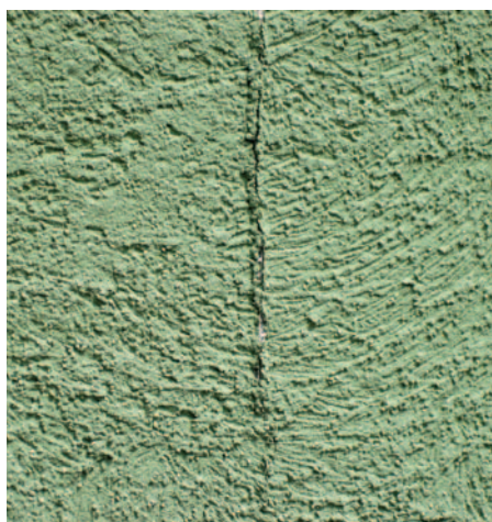
3–5. kép. Rögzítési/rögzülési hiányosság okozta kéregrepedések száraz építőlemezre felépített THR-eken
