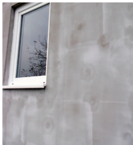
1–2. kép. A hőszigetelés felrögzítése csak dübelezéssel, az ún. „T” fugákban és táblaközepeken történt, beton- és téglafalhoz alkalmas dübeltípussal
