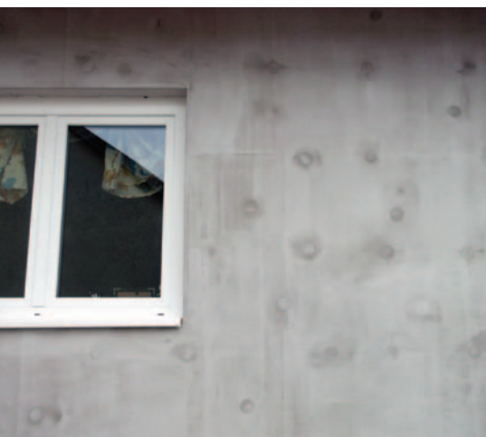
1–2. kép. A hőszigetelés felrögzítése csak dübelezéssel, az ún. „T” fugákban és táblaközepeken történt, beton- és téglafalhoz alkalmas dübeltípussal
