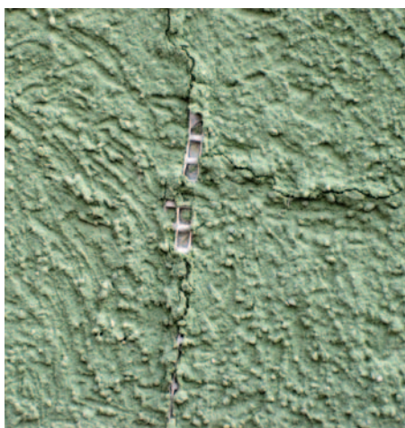
3–5. kép. Rögzítési/rögzülési hiányosság okozta kéregrepedések száraz építőlemezre felépített THR-eken
