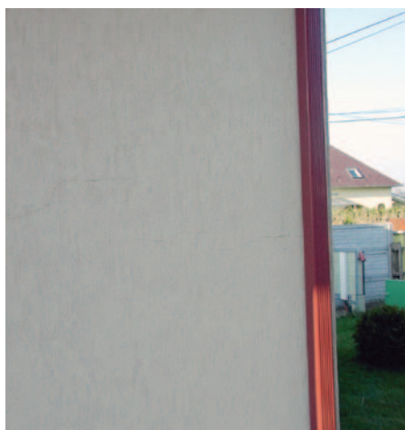
6–7. kép. Kéregrepedések „gyorsházon”
