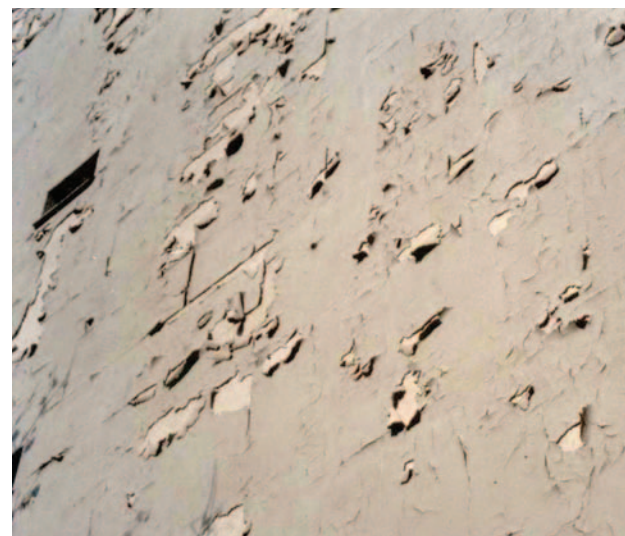
4–5. kép. A kiváló festék „eltépte” a fáradt vékonyvakolatot
