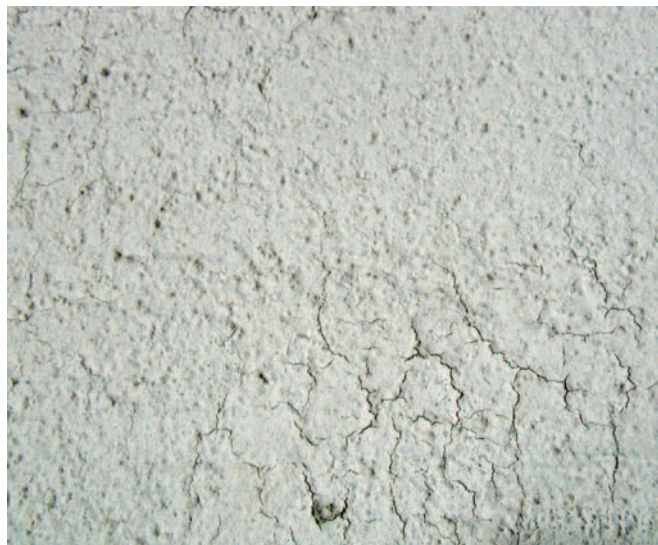
3. kép. Az úgynevezett leveles leválás
