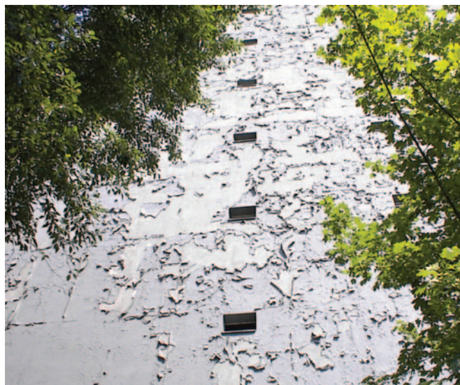
3. kép. Az úgynevezett leveles leválás
