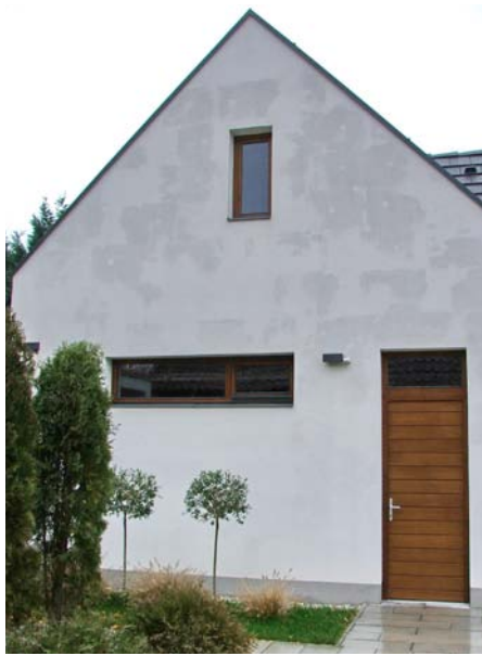
23. kép. Visszatérően átázó felület
