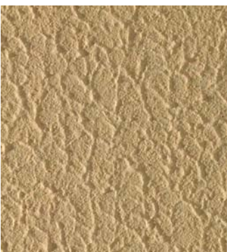
9. kép. hengerelt vékonyvakolat filc hengerrel
