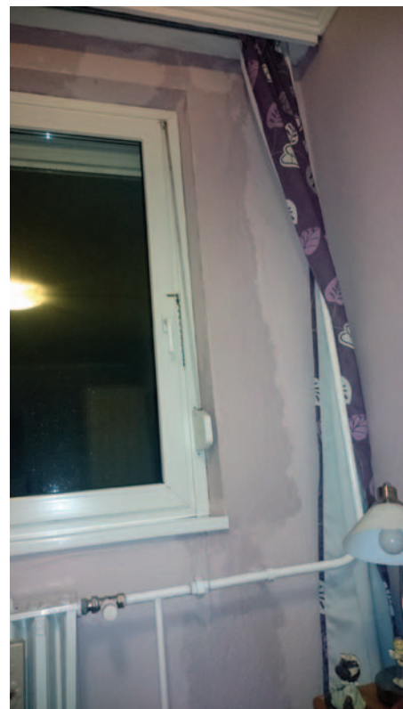
1. kép. Ablak fölött és mellett erős vízbeszivárgás
