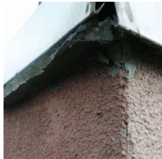
5–6. kép. A sikertelen javítási próbálkozás is tönkrement
