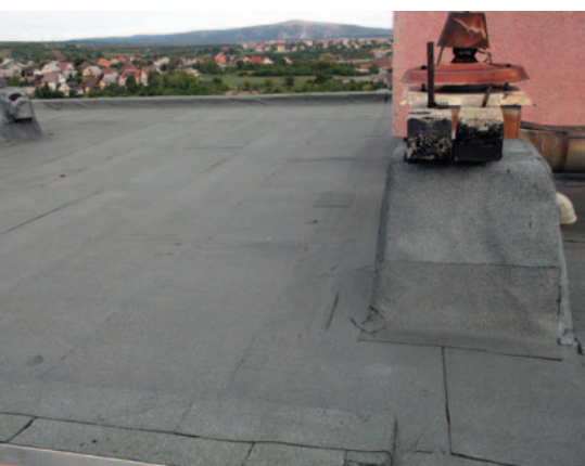
7–8. kép. Tetőfelújítás elhagyott páraszellőzőkkel
