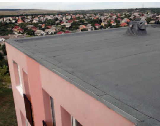
2. ábra. Ha a THR felül (is) zárt, nincs tábla mögötti csorgás (Megjegyzés: a csak pontokban történő ragasztásnak számtalan más kedvezőtlen következménye is van, de jelen esetben csak a beázás vizsgáldásunk tárgya.)
