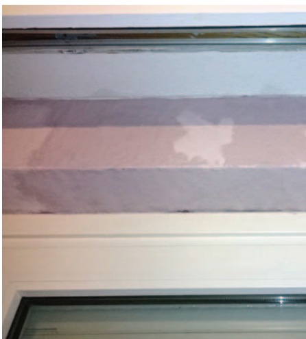
4. kép. Ablak fölötti beázás panelillesztési hézag miatt
