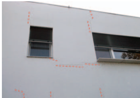
1–2. kép. Jellemző repedések helye
