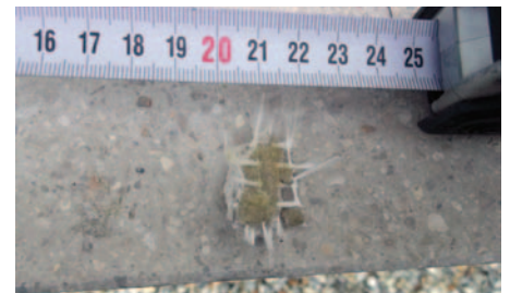
7. kép. A kőzetgyapot és az üvegszövet közötti ragasztótöréget nem éri el az 1 mm-t! Figyelem: nem látható a kőzetgyapot felületen kötelező előglettelés a hálózást megelőzően! Szakmai szabályok szerint a felületkiegyenlítést a hálózás előtt kell elvégezni és nem azt követően.
